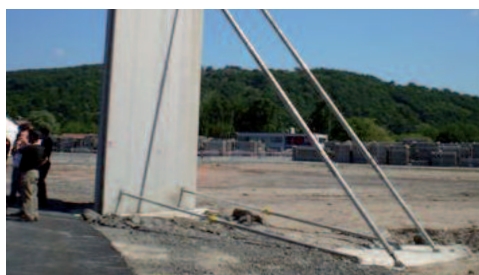
10 Étaçon de pied pour faire un stabilisateur
