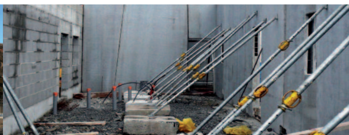
8 Sur prémurs de 3 mètres.
